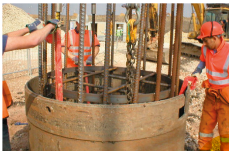
Foto 1. Colocación de armadura en pilote con camisa de chapa de protección
