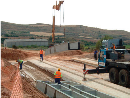
Foto 1: Piezas acopiadas y grúa apoyada sobre los cordones de cimentación.
