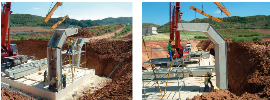
Foto 9. Secuencia de colocación. Regulación del apoyo y apuntalamiento. - Foto 10: Secuencia de colocación de la segunda pieza.
