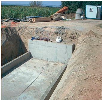
Foto 1: Muro de reacción y base de la plataforma de deslizamiento
