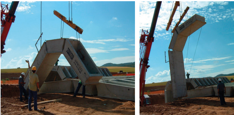
Fotos 4 y 5: Secuencia de izado: La pieza se levanta con el soporte de las plataformas auxiliares.
