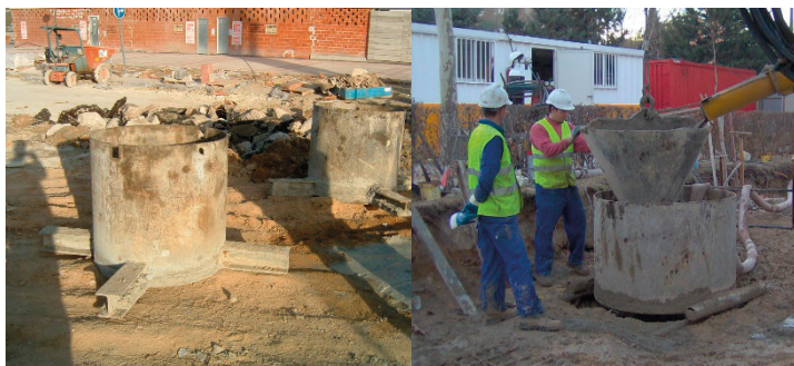
Foto 3 y 4. Ejemplos de tramos de camisa de 1 m con vigas estabilizadoras. Fase de hormigonado del pilote.
