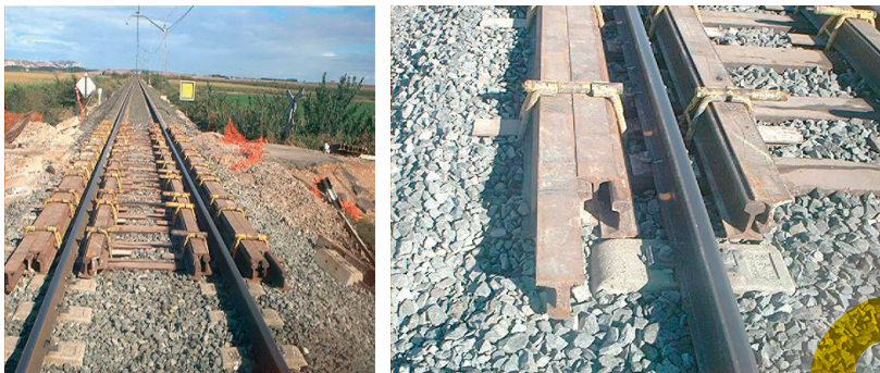
Foto 5. Distintos detalles del apeo de la vía
