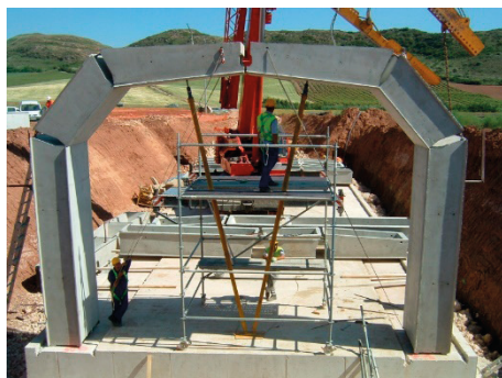
Foto 11: Secuencia de colocación. Conjunto estabilizado.
