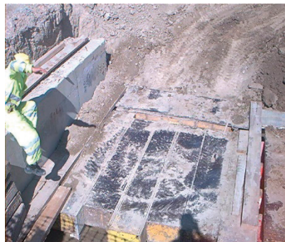
Fotos 2 y 3. Central hidráulica y elementos distanciadores entre gatos y muro de reacción.
