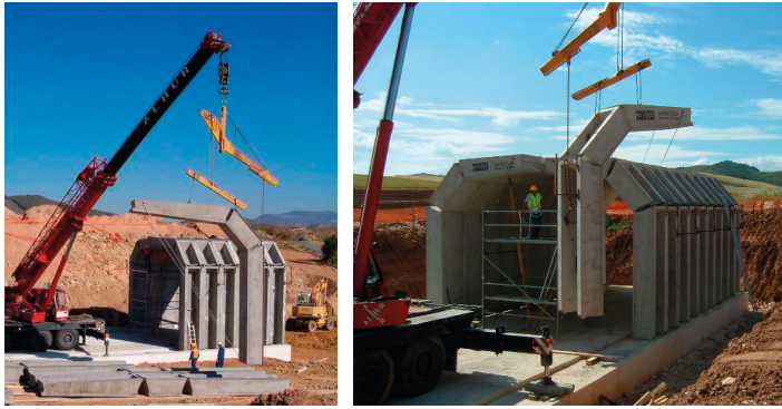
Fotos 6 y 7: Detalle del balancín y manipulación de la pieza con la grúa.
