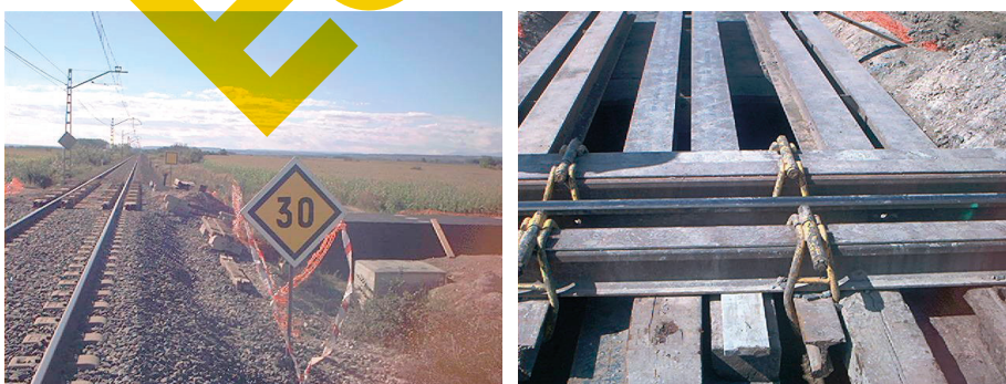
Foto 6. Limitación de velocidad a 30 km/h y vigas de maniobra bajo apeo de vías
