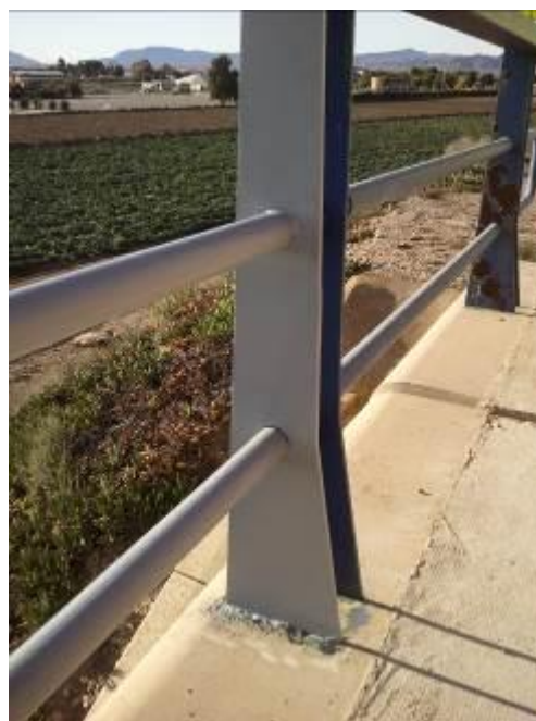
Figura 4. Aplicación de una capa general con una pintura antioxidante epoxi de dos componentes, con posibilidad de base agua, de al menos 600 horas de resistencia en ensayo de niebla salina según UNE-EN ISO 11997-1, en color RAL 7036 (Gris). Espesor nominal de película seca \geq 50 \mu\text{m} .
