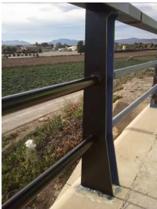
Figura 5. Aplicación de una capa intermedia de ligante epoxídico rico en oligisto micáceo altamente laminar con un espesor mínimo de 150 µm, en color RAL 9005 (Negro).
