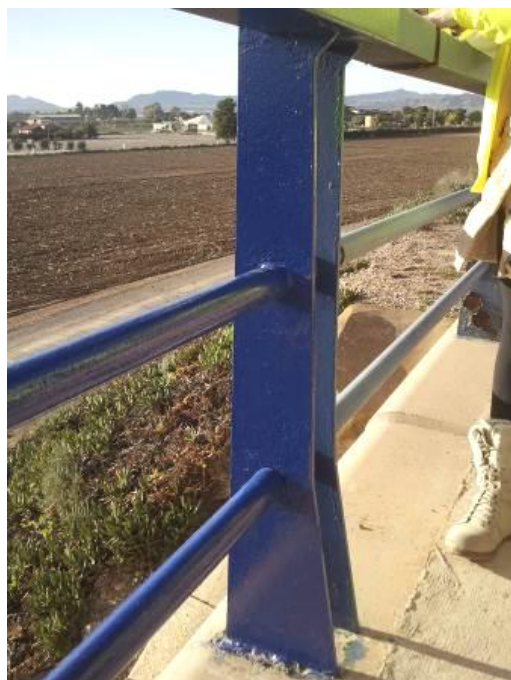
Figura 6. Aplicación de una capa de acabado con ligante base silicona de alta resistencia a intemperie, de espesor mínimo de 50 micras por capa, de color RAL 5002 (azul nuclear).
