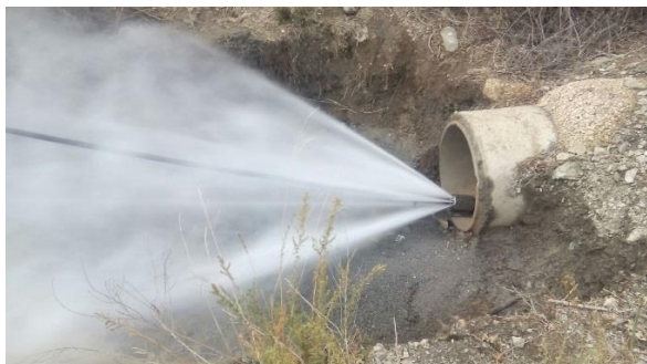
Fotos 3 y 4. Detalle de la manguera de alta presión con toberas especiales, normalmente llamadas tejas, que con sus chorros y su forma plana y pesada se arrastra avanzando por el fondo de las tuberías impulsando hacia atrás todos los lodos y/o residuos acumulados.
