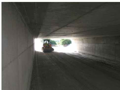
Fotos 5 y 6. El material es acopiado a la salida del marco por la miniretroexcavadora.
