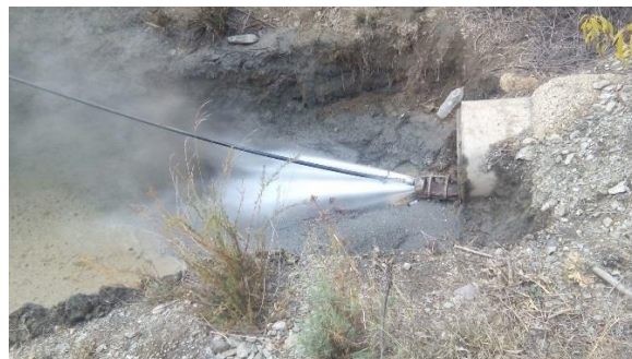
Fotos 3 y 4. Detalle de la manguera de alta presión con toberas especiales, normalmente llamadas tejas, que con sus chorros y su forma plana y pesada se arrastra avanzando por el fondo de las tuberías impulsando hacia atrás todos los lodos y/o residuos acumulados.
