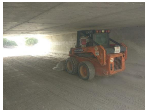
Fotos 5 y 6. El material es acopiado a la salida del marco por la miniretroexcavadora.
