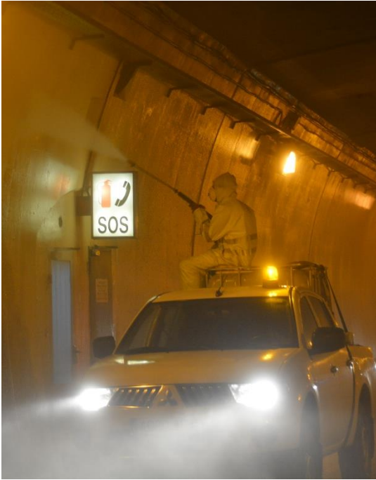
Figura 5. Aplicación de detergente
