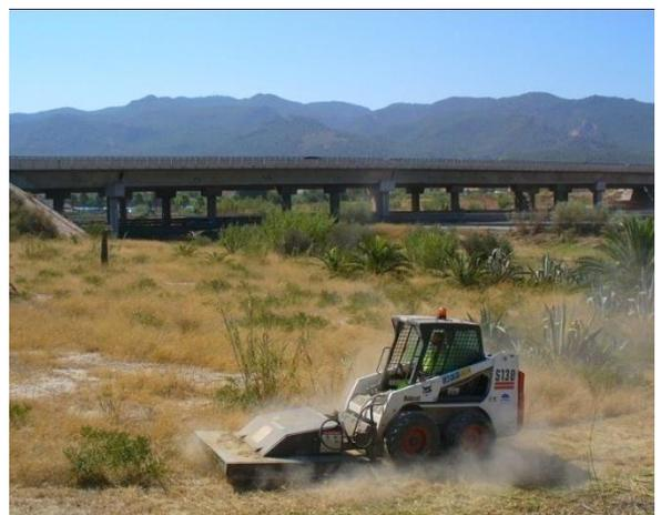
Figura 5. Despeje de vegetación mecanizado
